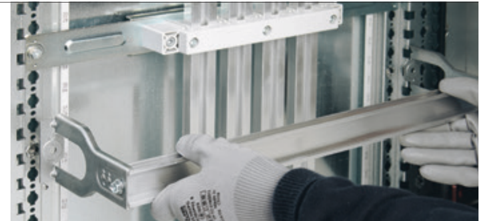
Fixation des rails en 2 points seulement sur écrous-cages
